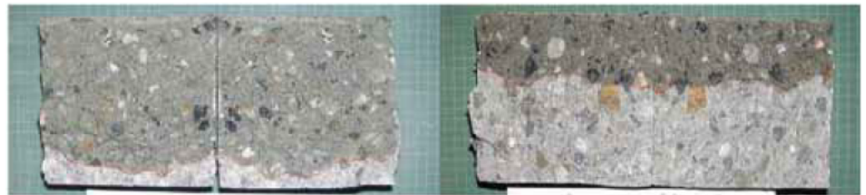
無処理：水の浸透深さが深い
