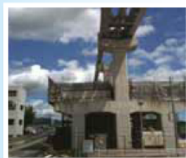
高架橋・壁高欄
